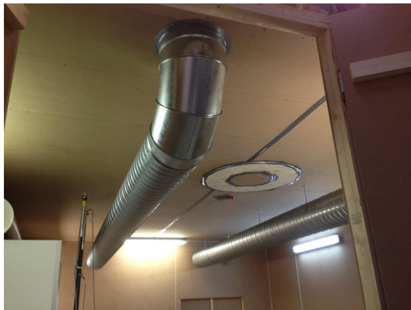
Figur 18 – Der installeres i alt 2 hulkanaler, hvoraf den ene tættest placeret stinkskalet benyttes i nærværende forsøg.
