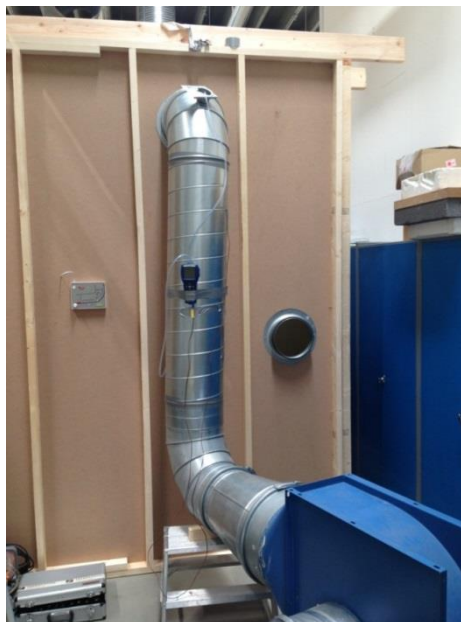
Figur 16 – MBU kanalforbundet med ekstern ventilator. Trykket over MBUén måles med et TSI differensstryk-mikromanometer. Til venstre for kanalen ses en DWYER trykmåler, som måler trykdifferensen mellem i målerummet og omgivelserne. Til højre for kanalen ses et af overstrømshullerne, som i dette tilfælde er åbent.
