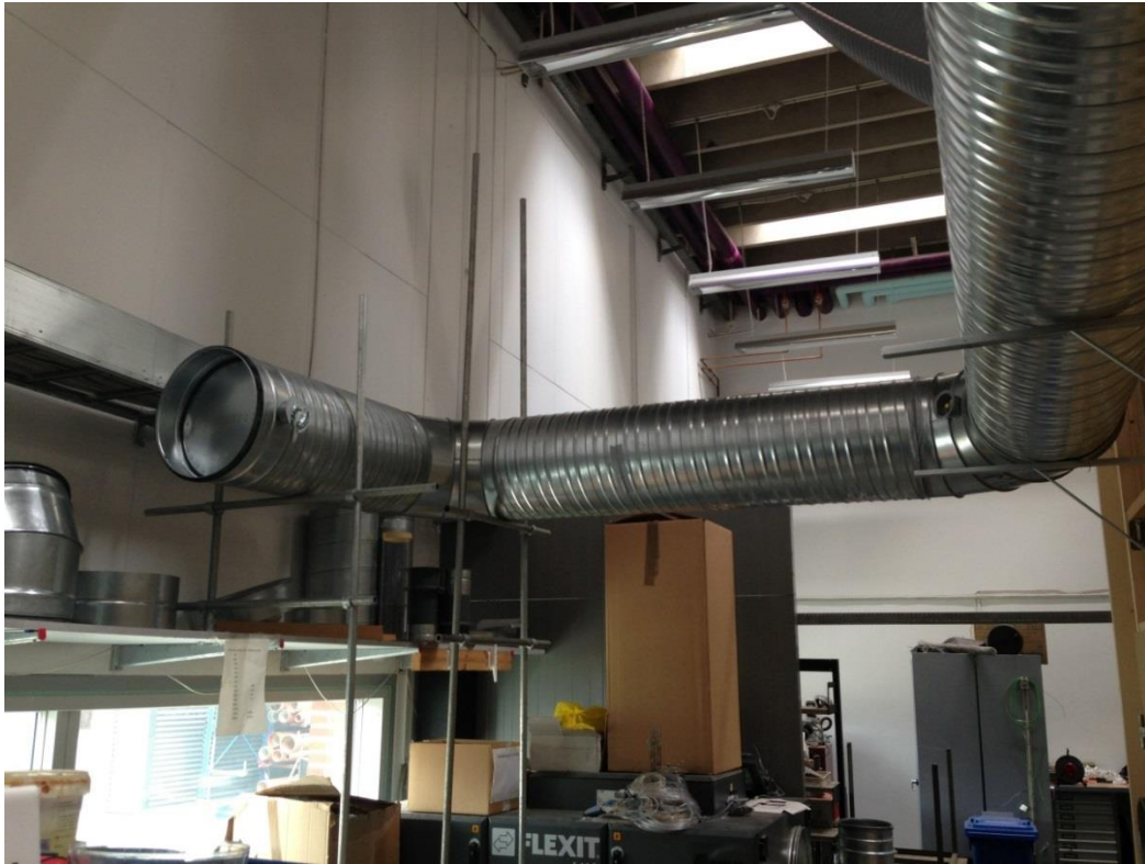
Figur 10 – Målebøjning, lige stykke, bøjning, spjæld, og stativer til understøttelse af kanalerne. Spjældet er her lukket helt af til referencemålingerne, og flexslangen til udsugningen er af samme årsag ikke påsat.
