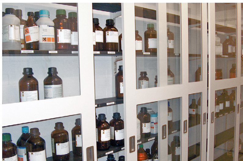
Reoler forsynet med skydelåger og ventilation
