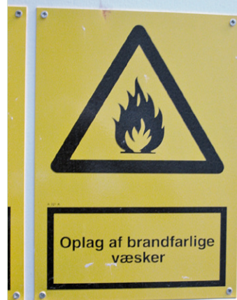
Skiltning ved oplag af brandfarlige væsker
