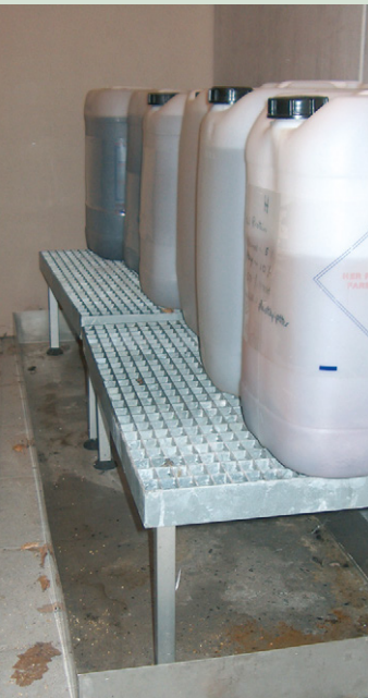
Spildbakker begrænser spredning af spild
