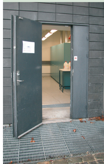
Niveaufri adgang til kemikalielager
